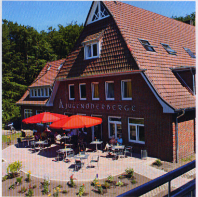
Das vorhandene Gebäude der Jugendherberge Bad Zwischenahn erhielt jetzt eine neue, attraktive Terasse mit Blick auf das Wasser
